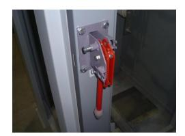
Установка сектора рычага и соединение тягой в сборе с приводом
