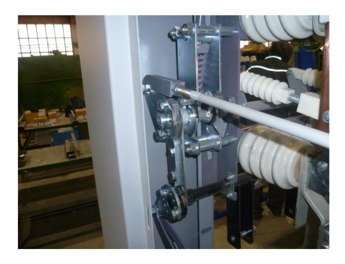
Установка привода ПР-10 для оперирования заземляющими ножами выключателя.
