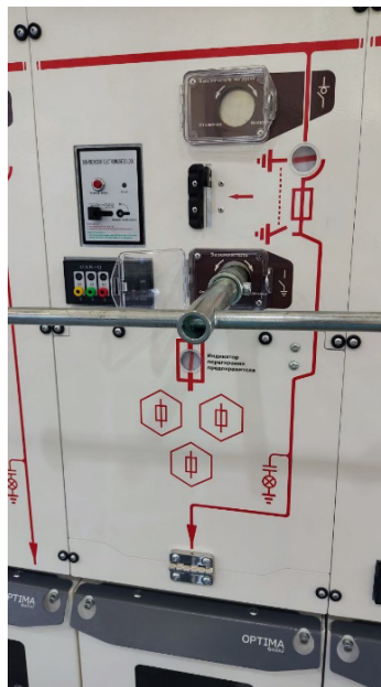
Рисунок 5 – Оперирование заземляющим разъединителем
