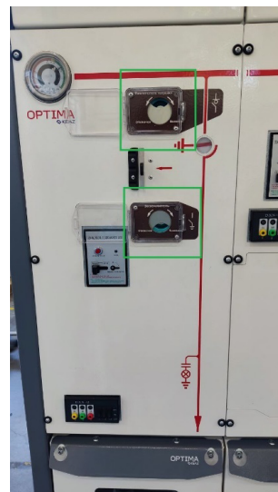
Рисунок 3 – Расположение отверстий для оперирования разъединителями
